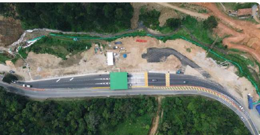
Fotografía 8. Ampliación peaje Amagá
