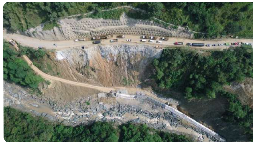
Fotografía 9. Obras vía existente sector Sinifaná
