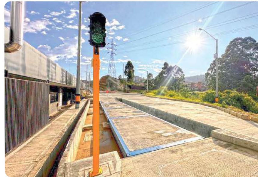
Fotografía 2. Área de pesaje Caldas
