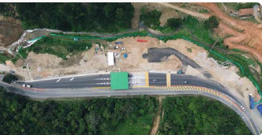
Fotografía 8. Ampliación peaje Amagá
