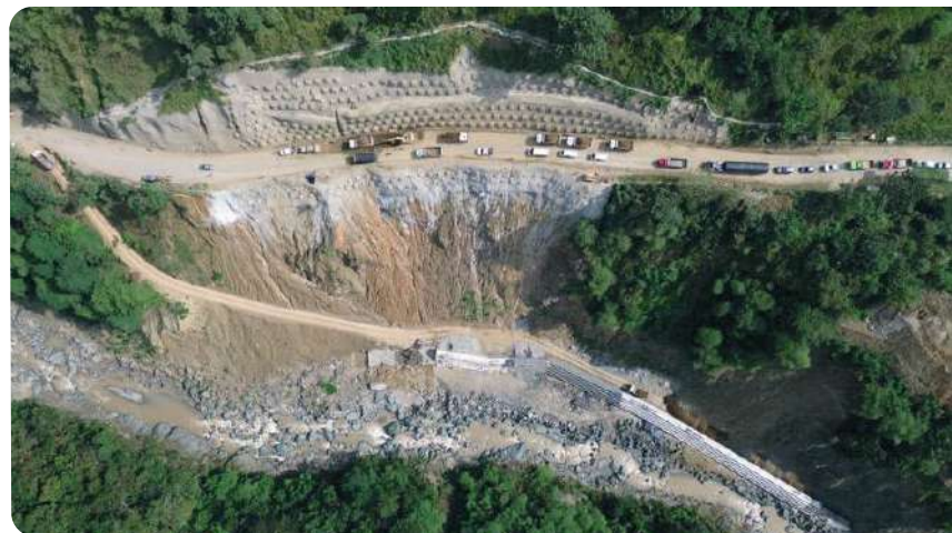
Fotografía 9. Obras vía existente sector Sinifaná
