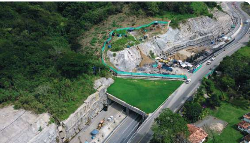
Fotografía 7. Ejecución de obras complementarias en el túnel falso de la UF2
