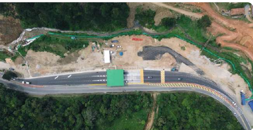
Fotografía 8. Ampliación peaje Amagá
