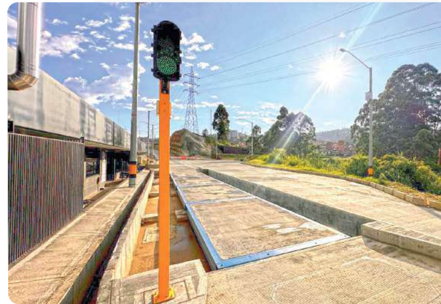
Fotografía 2. Área de pesaje Caldas
